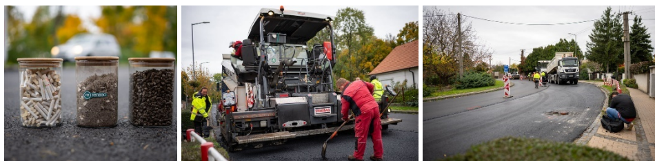
Obrázok 10: Pokládka obrusnej vrstvy SMA vozovky cesty II/521 v Malinove – 27.11.2025
