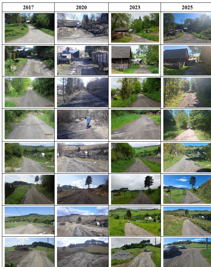
Obrázok 2: Pohľady autorov z rokov 2017 až 2025 na recyklovanú vozovku s využitím priemyselného odpadu (zmesný R-materiál)
